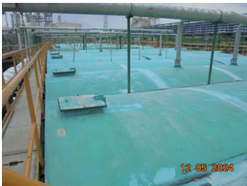
รูปที่ 3-33 ฝาปิดระบบบำบัดน้ำเสีย
