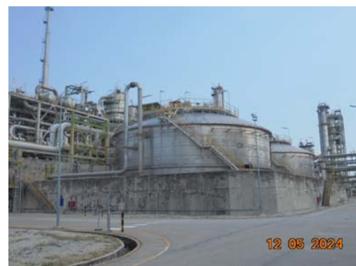
รูปที่ 3-67 คันคอนกรีตบริเวณที่เก็บกักวัตถุดิบ และผลิตภัณฑ์
