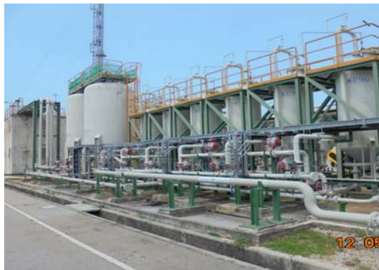
ระบบบำบัดน้ำเสียด้วยถ่านกัมมันต์
