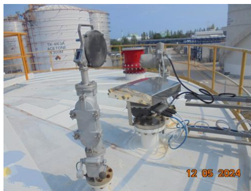
รูปที่ 3-71 Pressure/Vacuum Vent Valve
